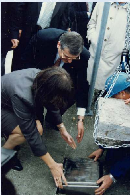
1996 — ACTO DE COLOCACIÓN DE LA PRIMERA PIEDRA DE LA LONJA CLIMATIZADA A CARGO DE LA MINISTRA DE AGRICULTURA Y PESCA, LOYOLA DE PALACIO.
